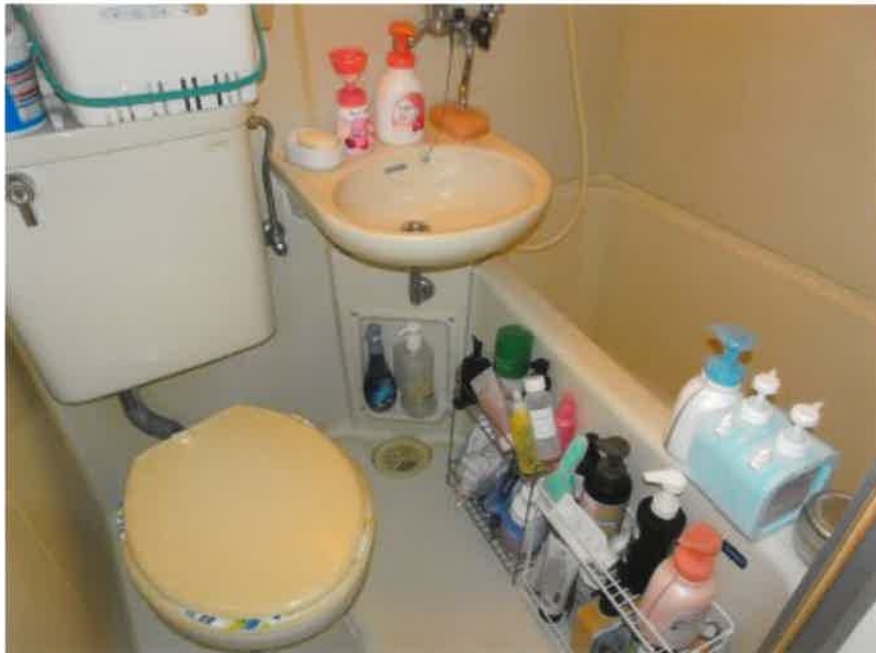
⑥ 建物内の状況 201号 UB
