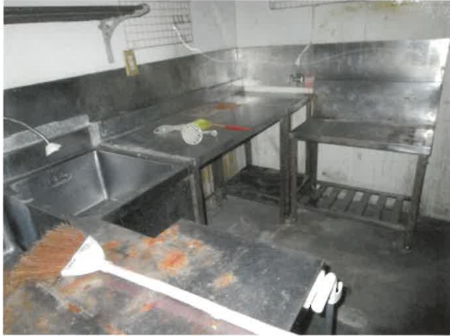
③ 建物内の状況 1階 厨房
