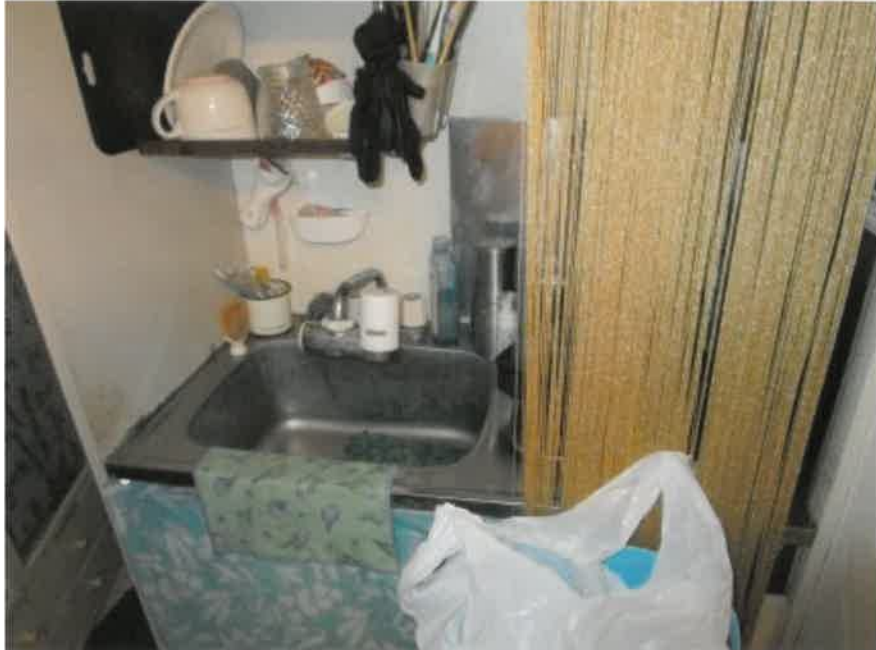
⑧ 建物内の状況 303号 流し台
