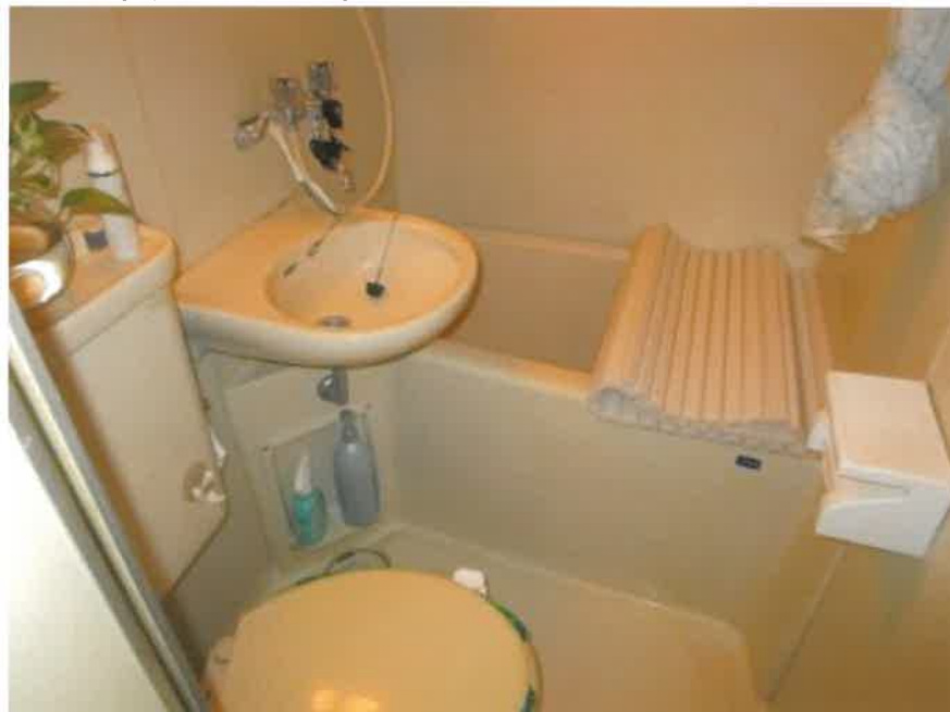
⑨ 建物内の状況 303号室 UB
