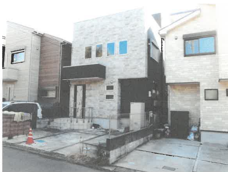
①目的建物全景
