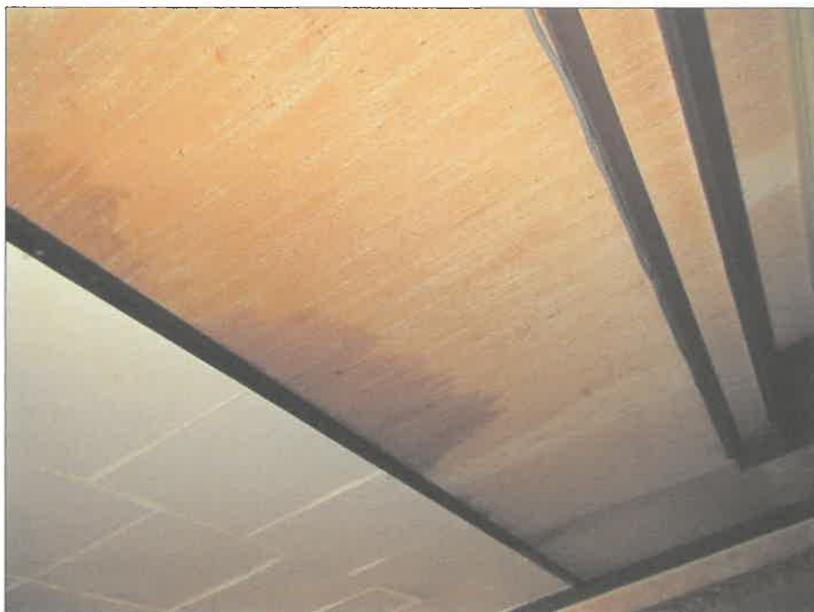
⑦上部を撮影
