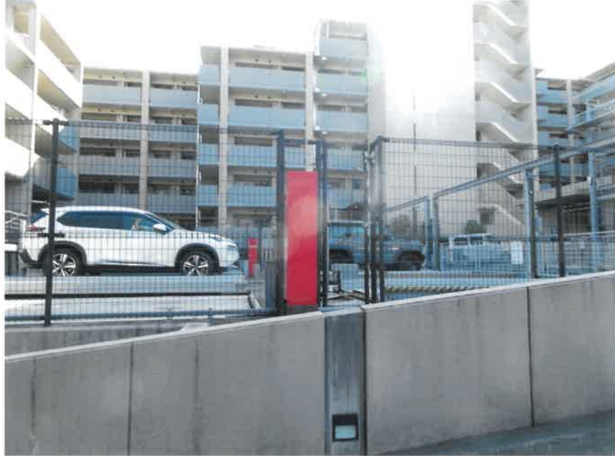
① 本建物を含む一棟の建物の外観（北方向から撮影）
