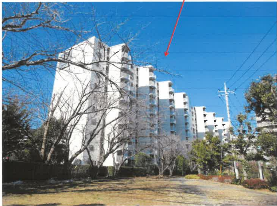
物件 1 の存する一棟の建物
