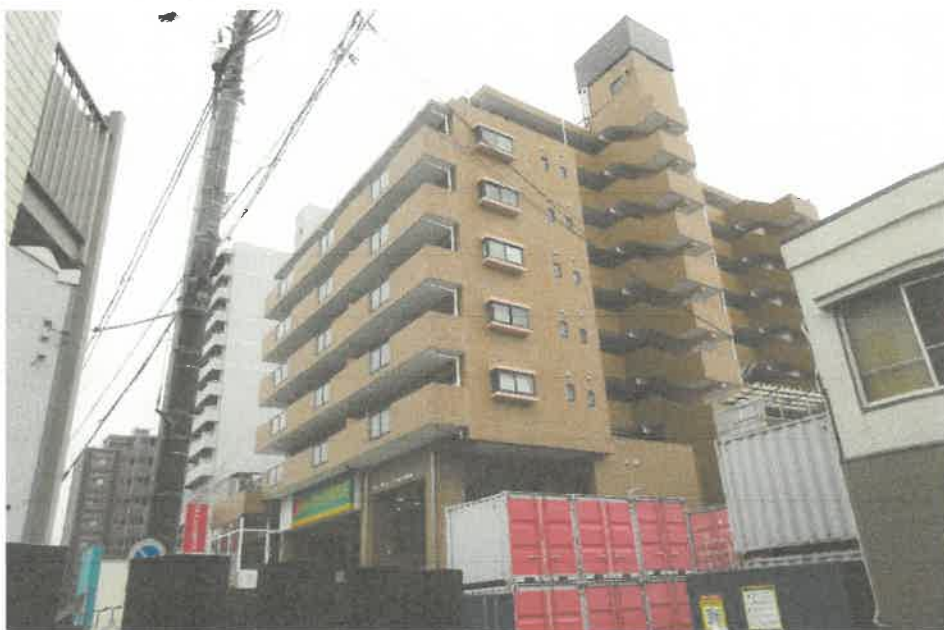
① 物件1を含む一棟の建物
