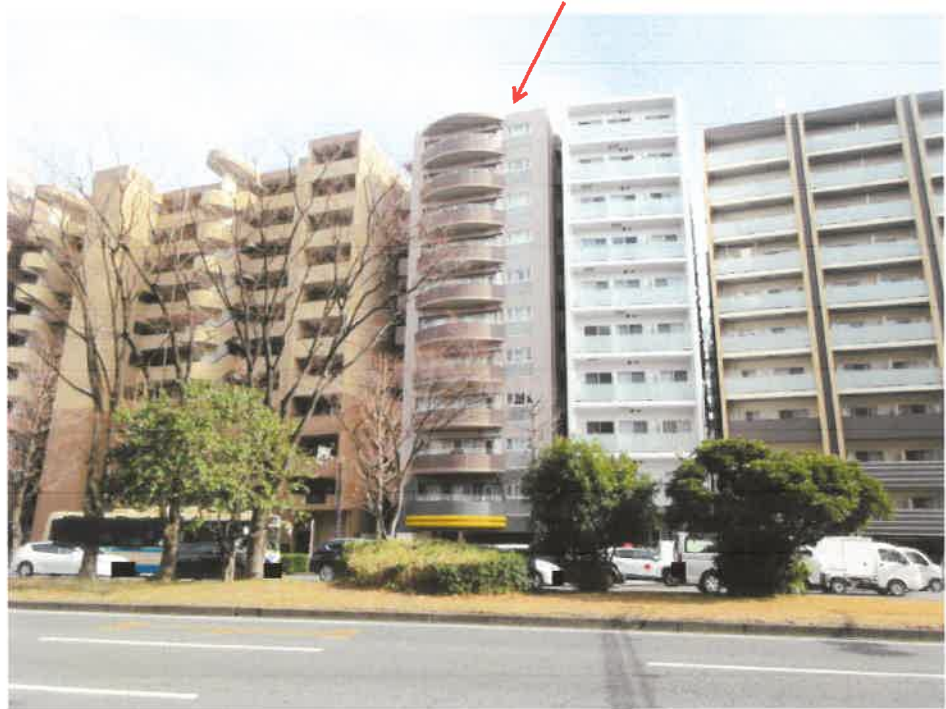
物件 1 の存する一棟の建物
