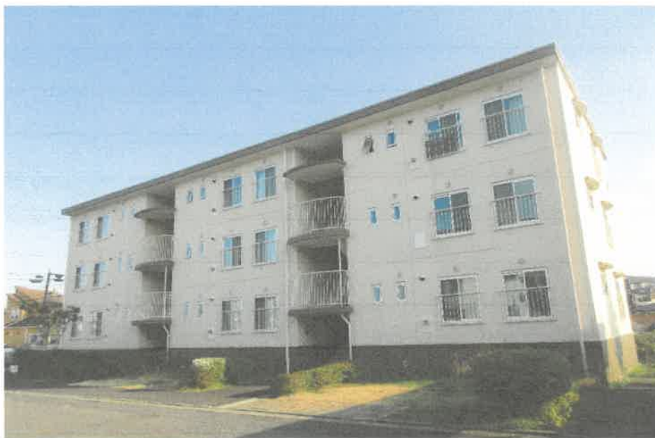
① 物件3を含む一棟の建物
