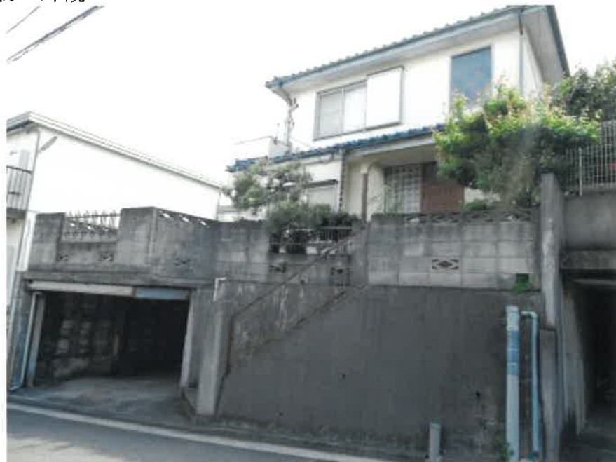
① 建物の外観
