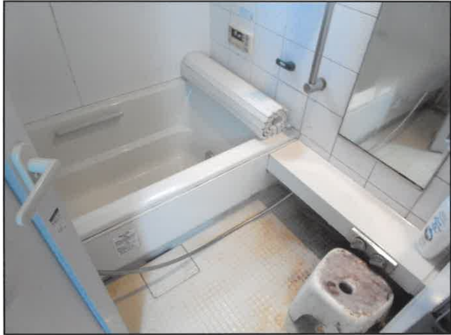
⑤ 建物内の状況－浴室(2階)
