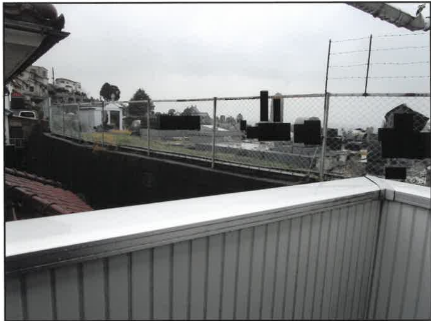
⑥ 本土地北側の墓地(2階バルコニーから見た状況)
