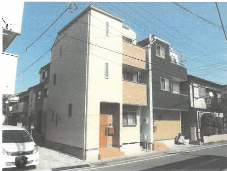
①目的建物全景
