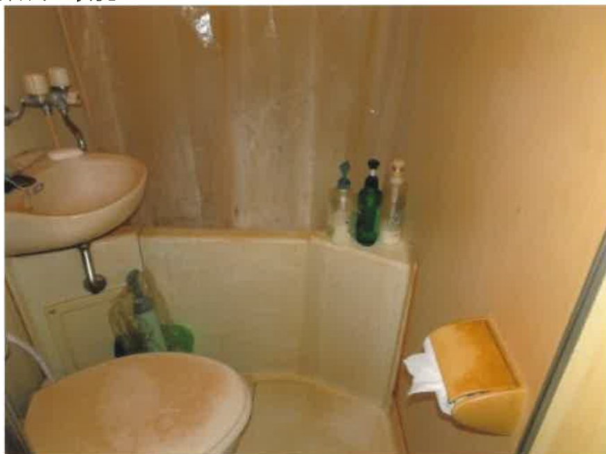
④ 建物内の状況
