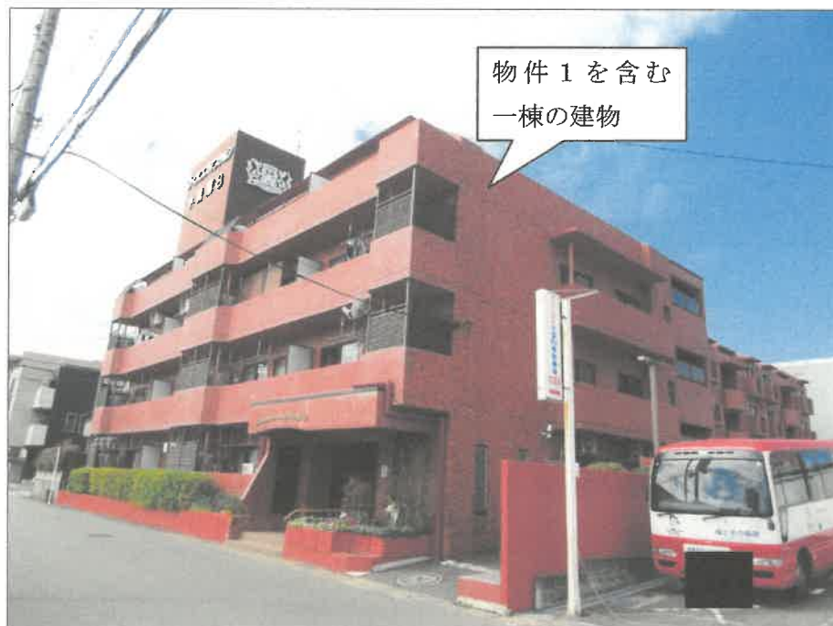
①外観（東方向から撮影）
