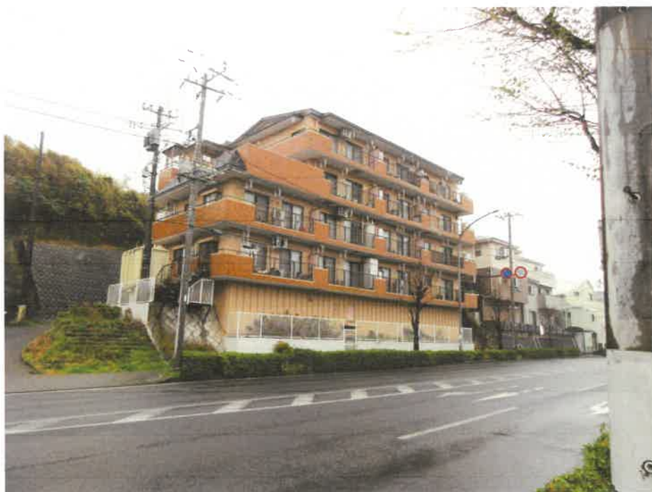
物件 1 の存する一棟の建物
