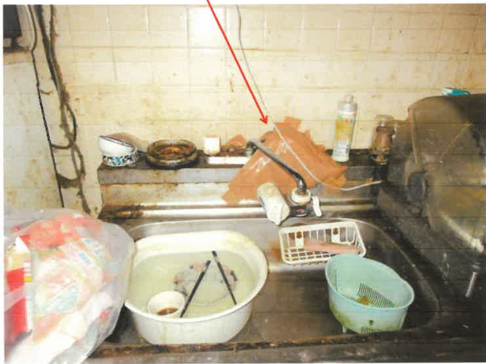
蛇口の損傷状況
