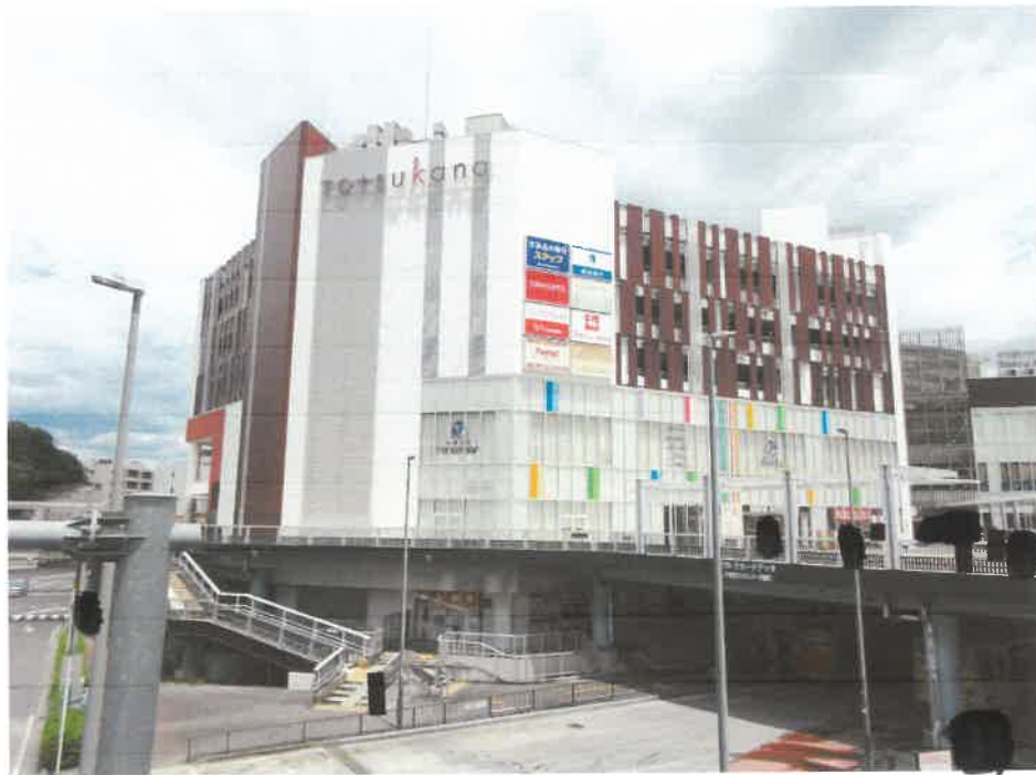
物件 1 の存する一棟の建物
