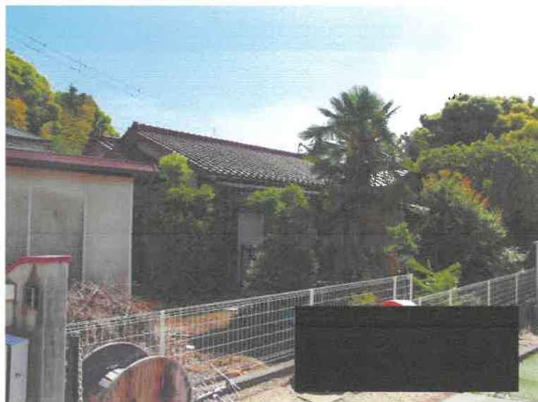
①目的建物全景
