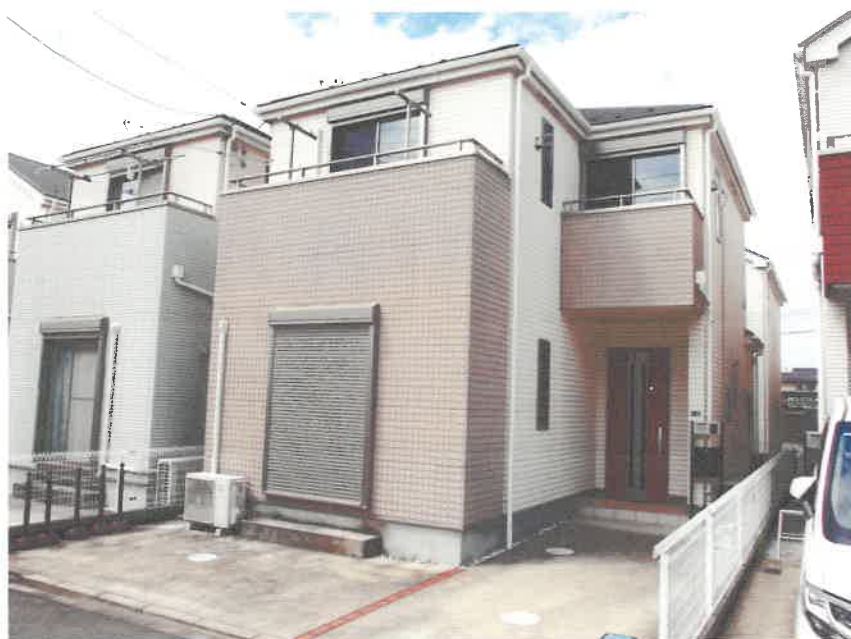
①目的建物全景
