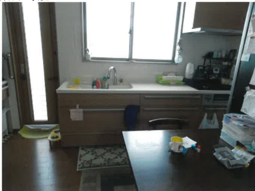
③ 建物内の状況
