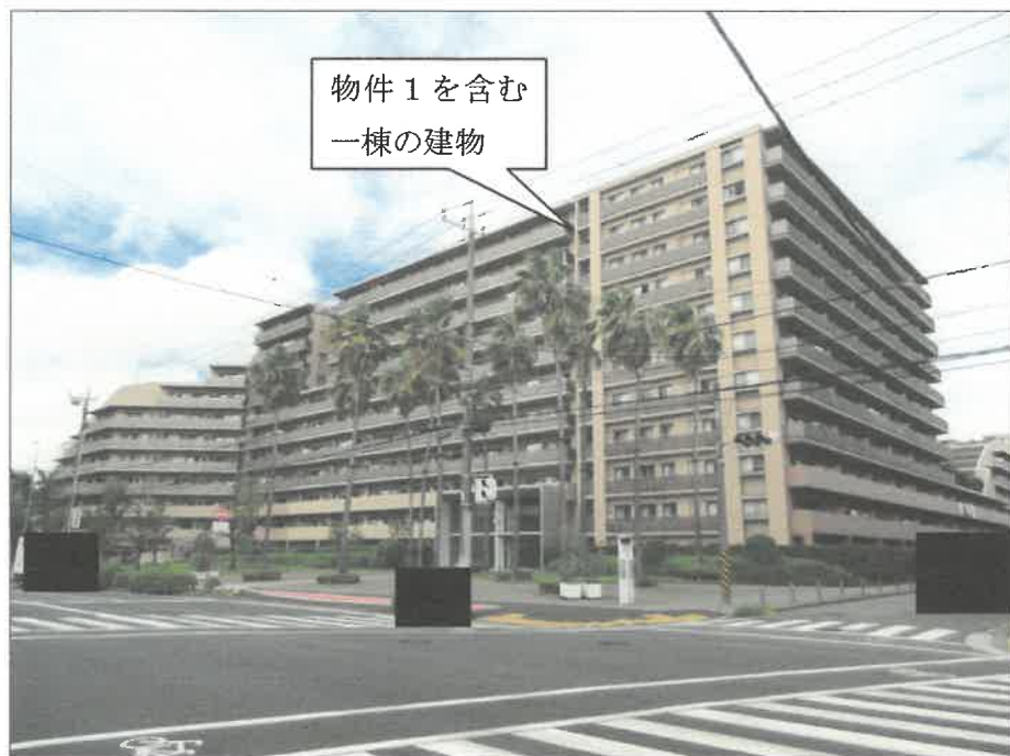
①外観（南西方向から撮影）
