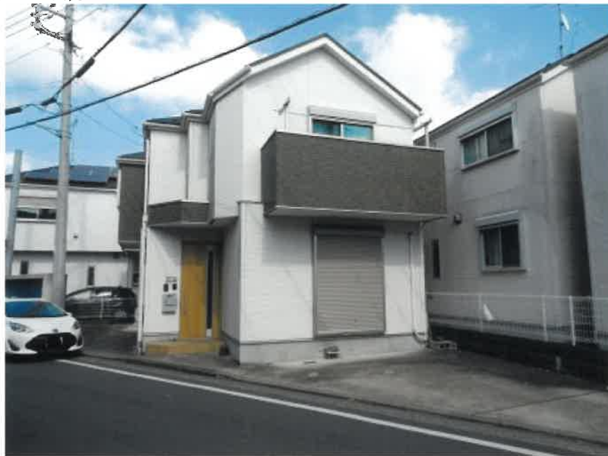
① 建物の外観
