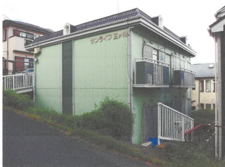
①目的建物全景
