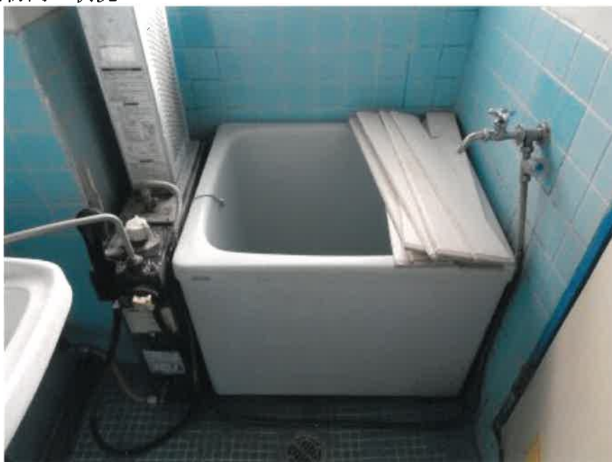
④ 建物内の状況
