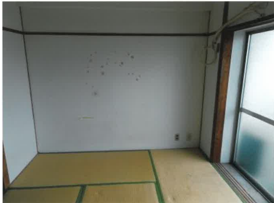
② 建物内の状況
