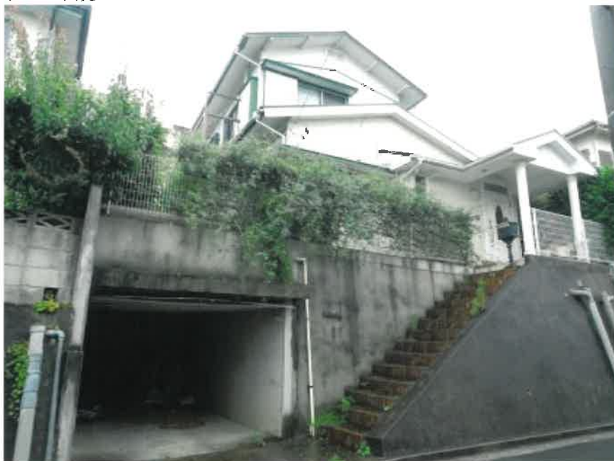
① 建物の外観
