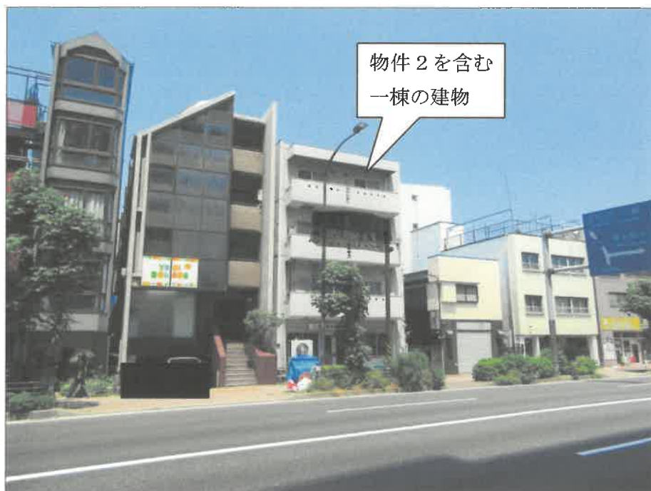
①外観（南西方向から撮影）
