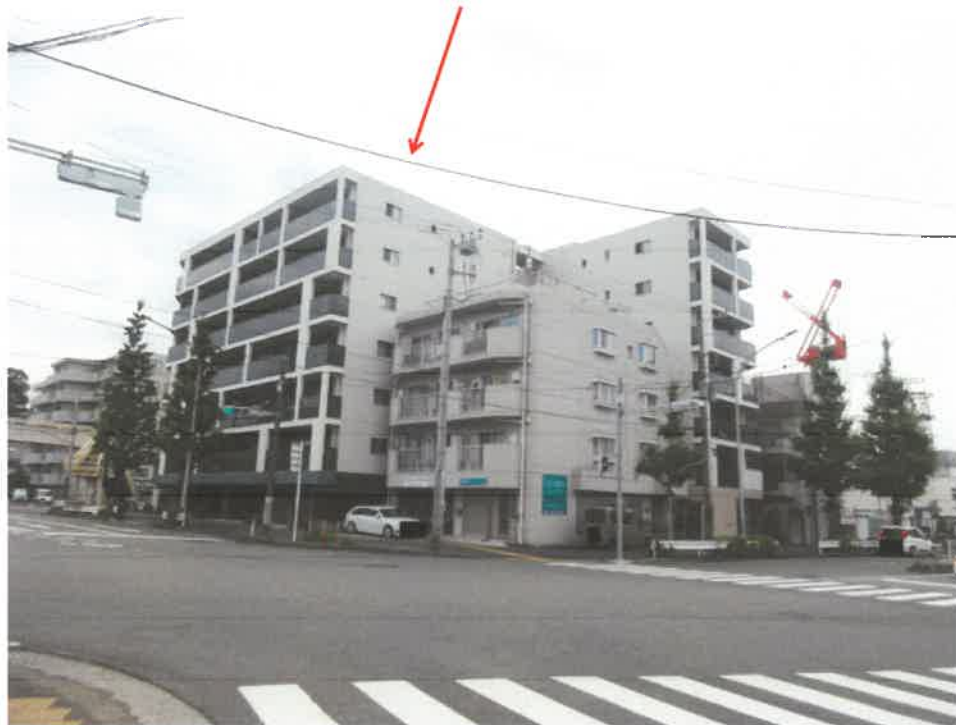
物件 1 の存する一棟の建物
