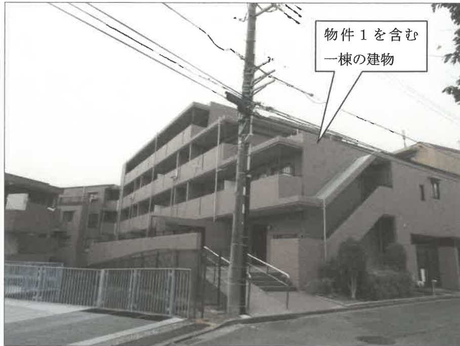
①外観（北東方向から撮影）
