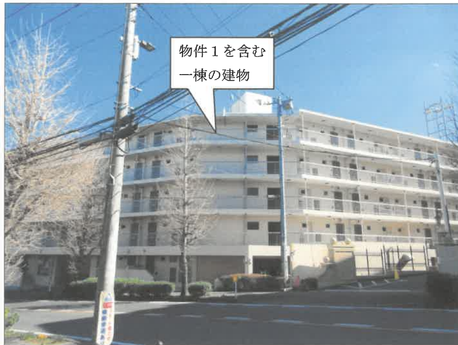
①外観（北西方向から撮影）
