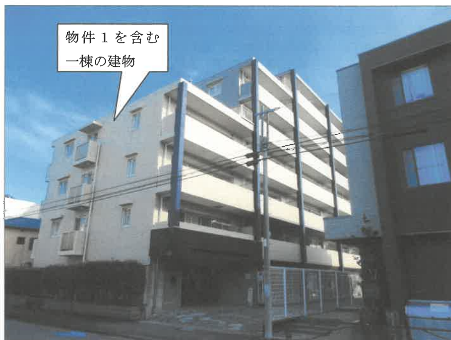
①外観（北西方向から撮影）
