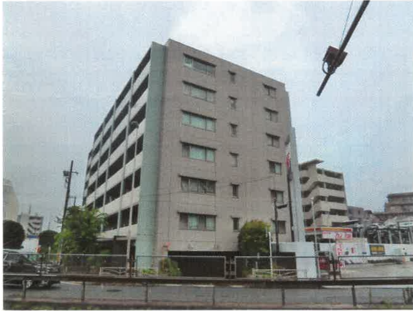
①受命物件 1 を含む一棟の建物の外観（南東方向から撮影）
