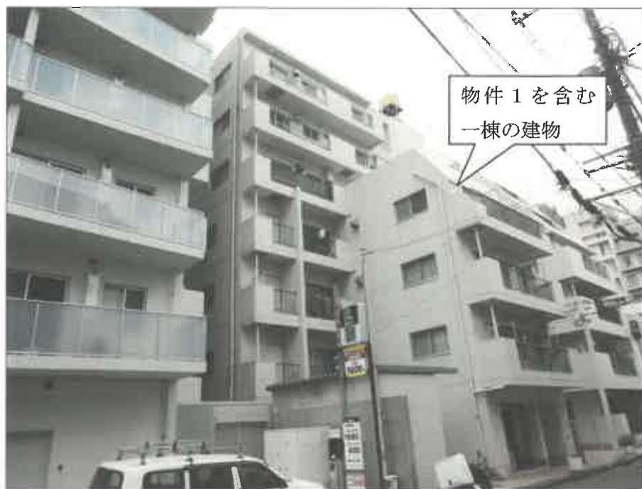
①外観（北東方向から撮影）
