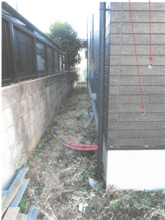
外壁の損傷
