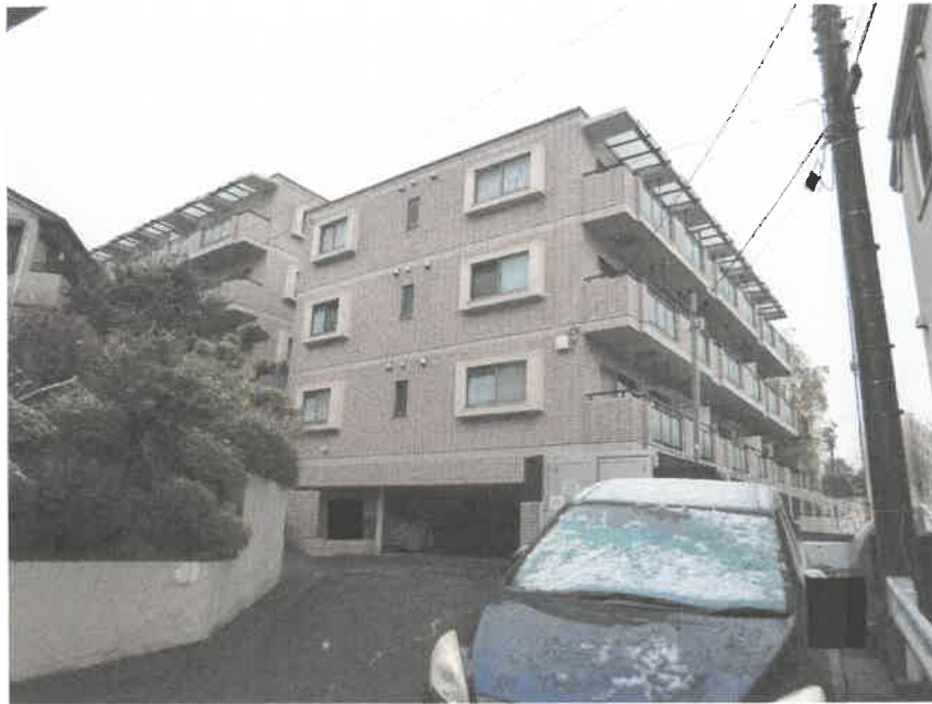
①受命物件1を含む一棟の建物の外観
