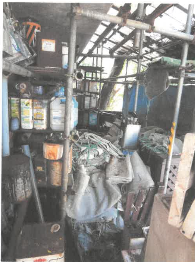
⑤下屋状部分の状況
