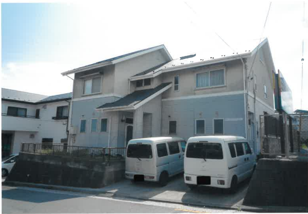
1 本件建物の外観
