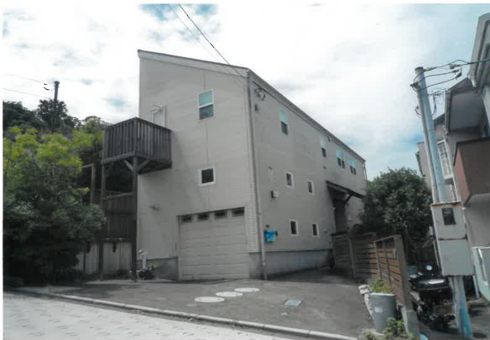
1 本件建物の外観
