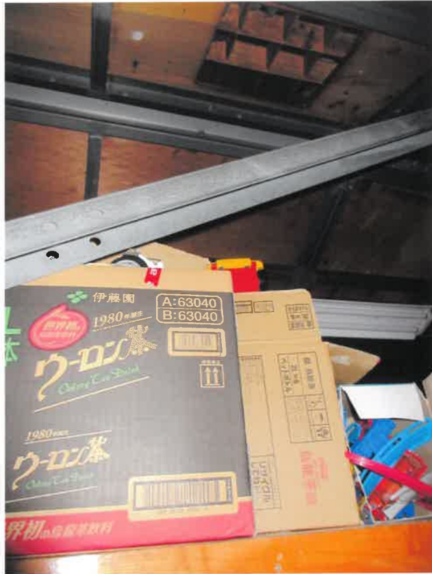
⑦ (屋根裏収納内部の状況 写真撮影位置方向なし)
