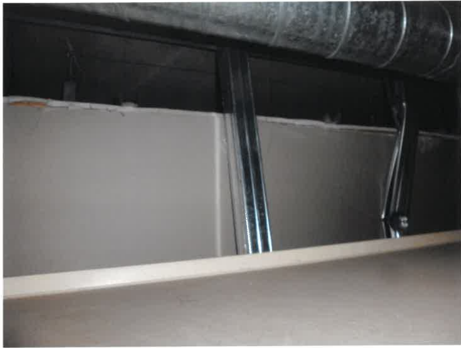
③ 101号室浴室点検口内部の状況 写真撮影位置方向なし
