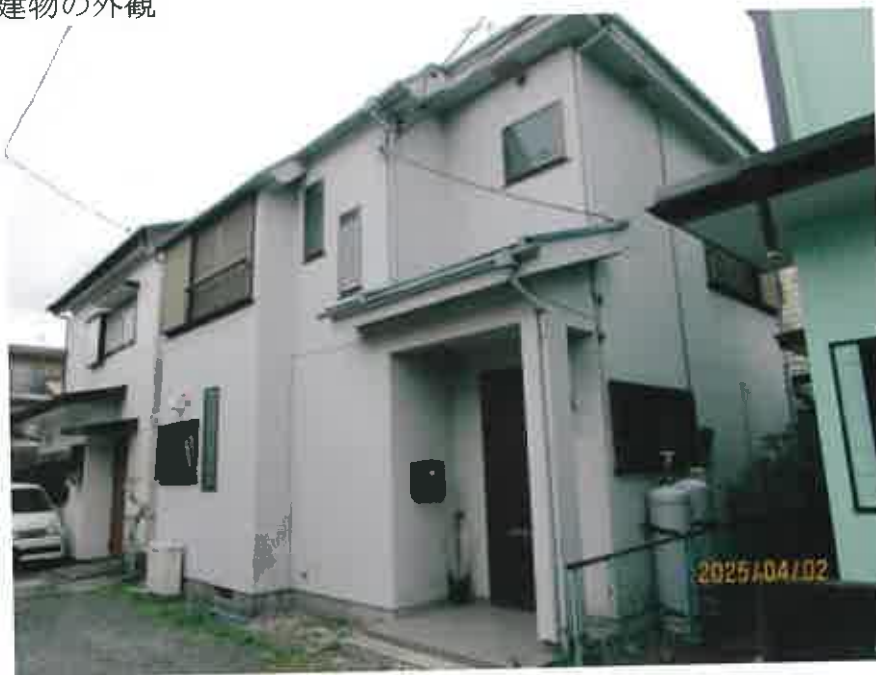
① 本建物の外観
