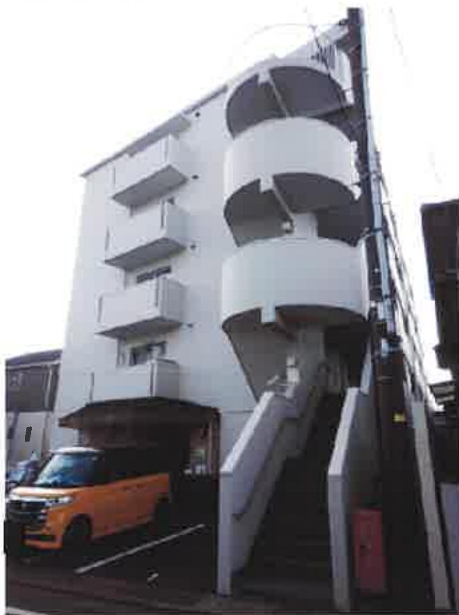
① 物件1を含む建物の外観
