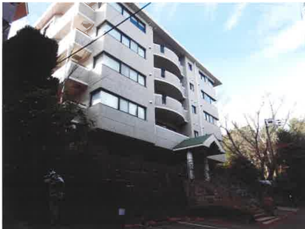
①物件1を含む建物の外観
