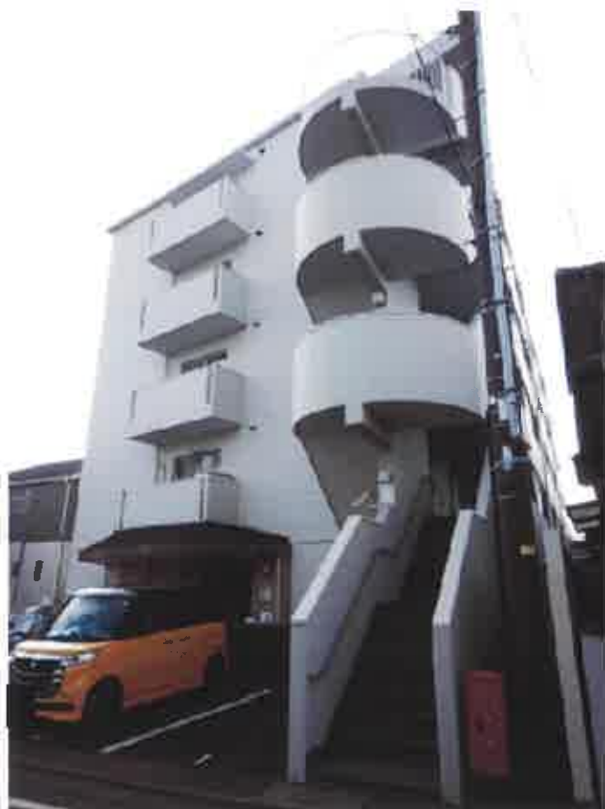
① 物件1を含む建物の外観
