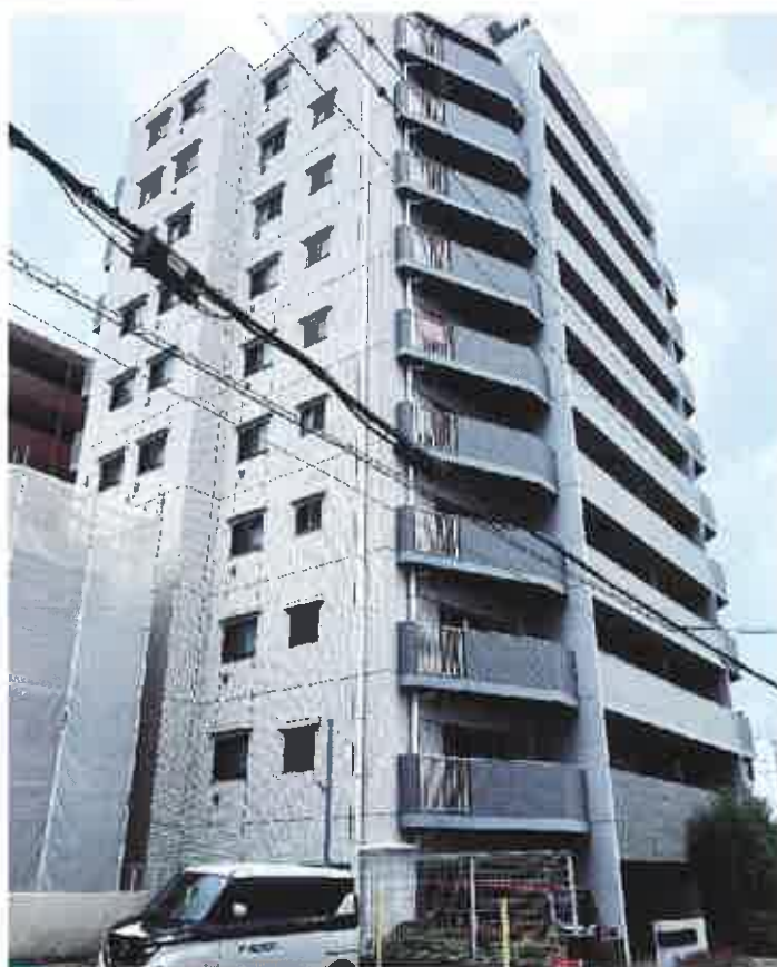
①物件1を含む建物の外観
