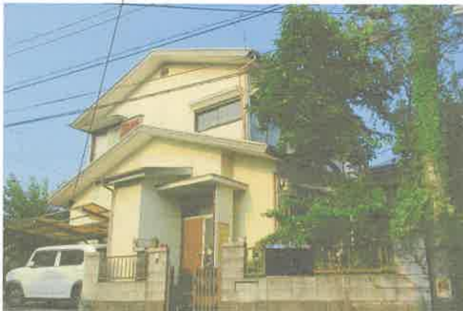
① カーポートの屋根の破損
