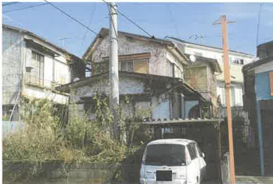
① 本土地上の電柱 軒下の破損
