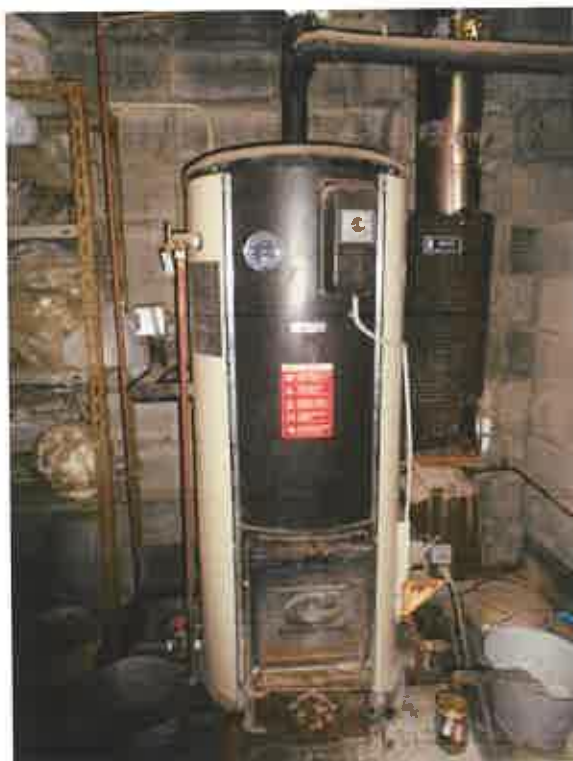
附属建物(1)内部
