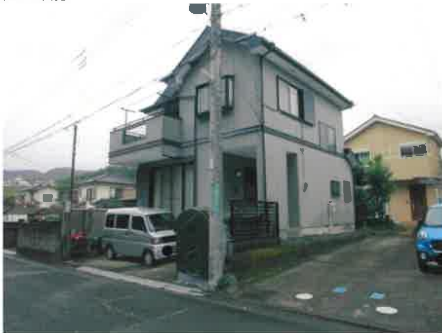
① 建物の外観
