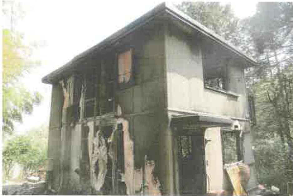
① 物件2 建物の状況
