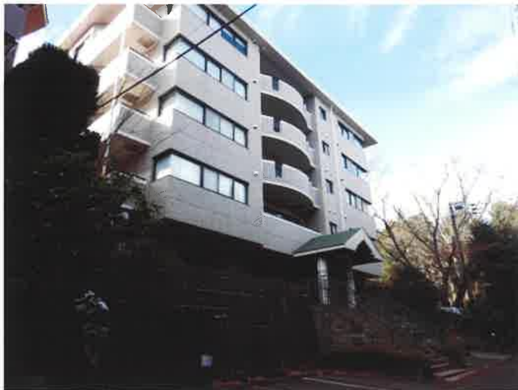
①物件1を含む建物の外観
