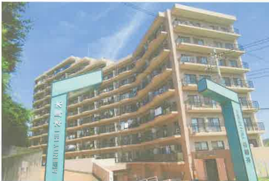
① 物件1を含む一棟の建物
